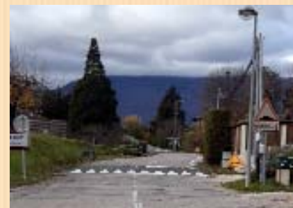
→ Entrée de la route après les travaux.
