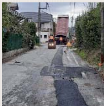
Rebouchage de la tranchée.
