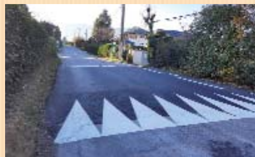
→ Croisement du chemin de la Vieille Route, après les travaux.
