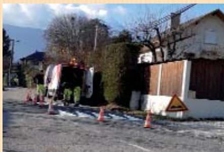
→ Réalisation du dos d'âne.
