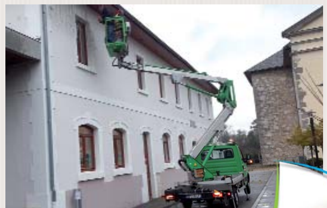
Installation des illuminations de Noël.
