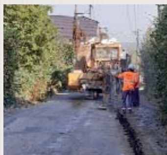
Le Crêt. Pose de la fibre en tranchée.
