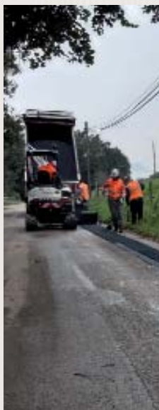
Le Crêt. Pose de la fibre en tranchée.
