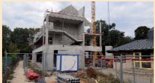
La construction progresse... ▲
