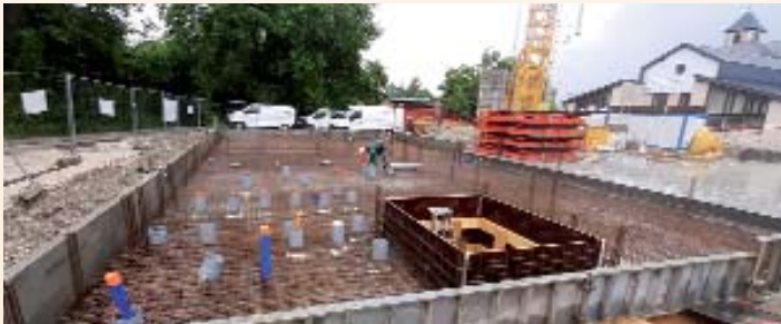
▲ Ferrailage de la dalle du rez-de-chaussée
