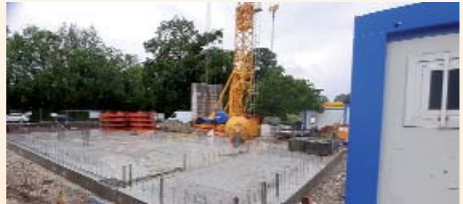
Coulage de la dalle du rez-de-chaussée ▲
