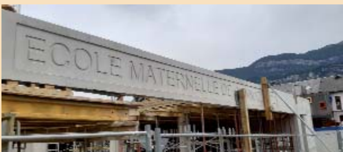
▲ Gravage de la dénomination du bâtiment
