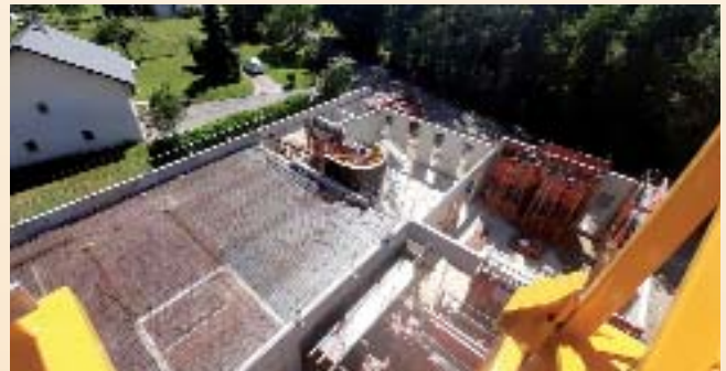
Ferrailage de la dalle du 1 er étage ▲
