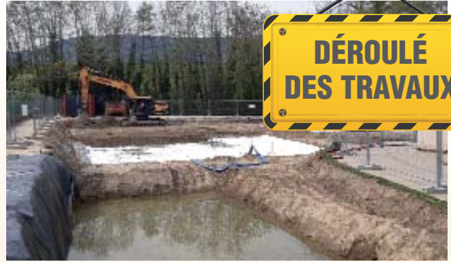
Création de la cuve de rétention d'eau pluviale ▲
