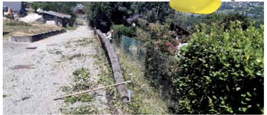
▲ Travaux de débroussaillage. ▼
