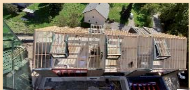
Mise en place de la charpente ▲
